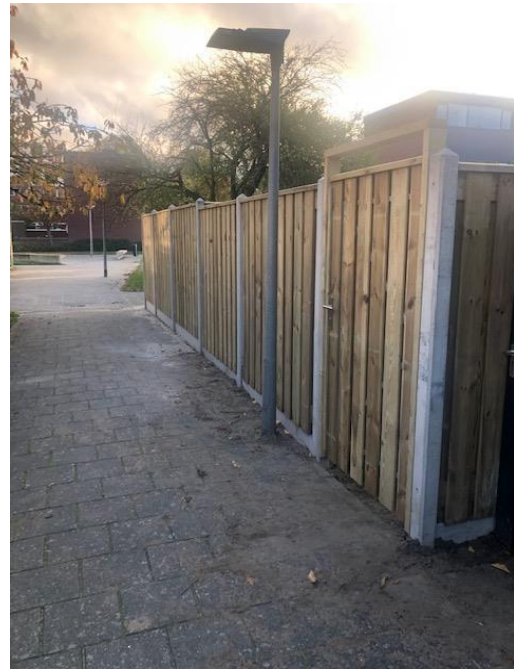
Situatie na plaatsen schutting
